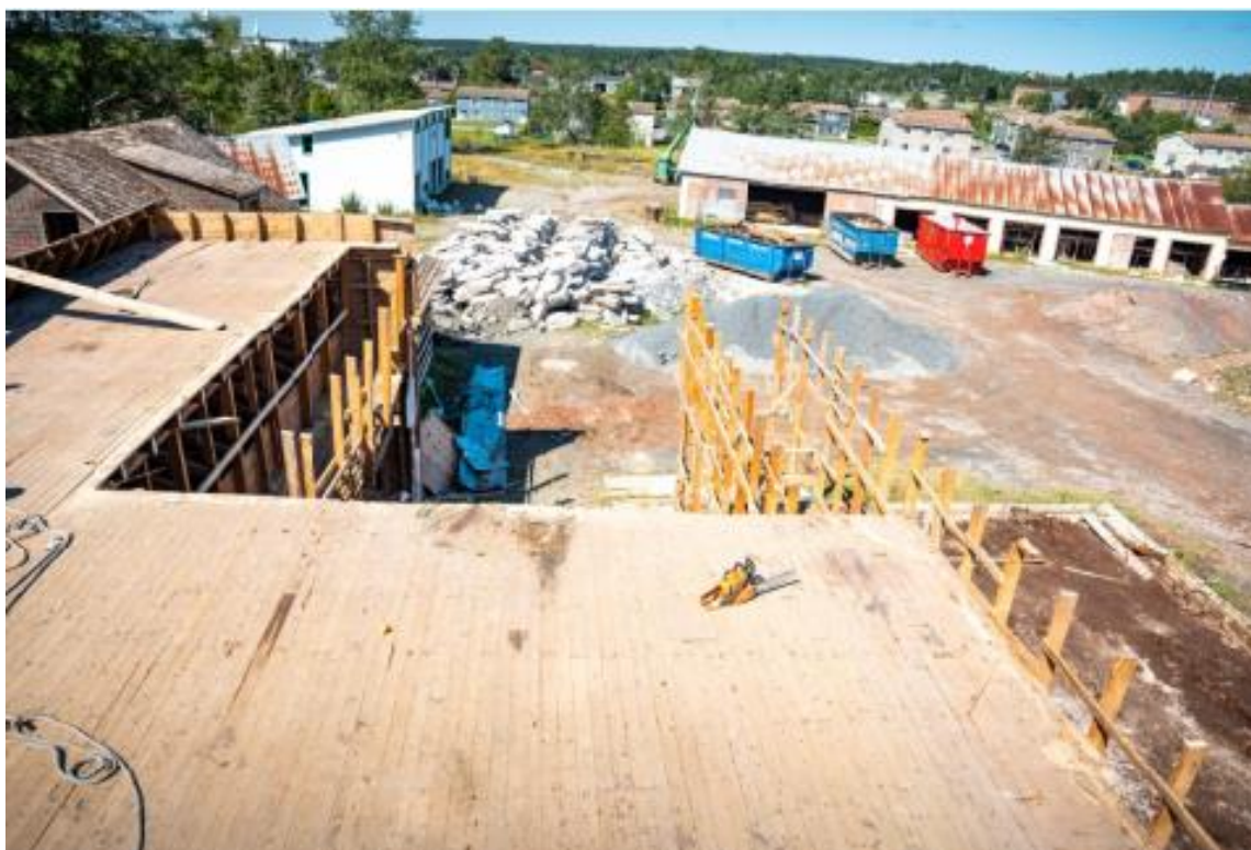
Vue d'ensemble du site avec conteneurs
