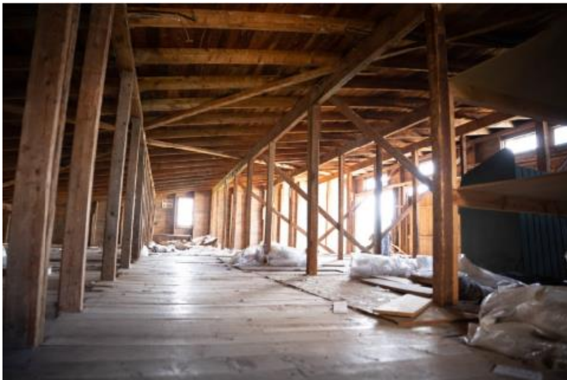
Intérieur du bâtiment avant le ménage et la déconstruction
