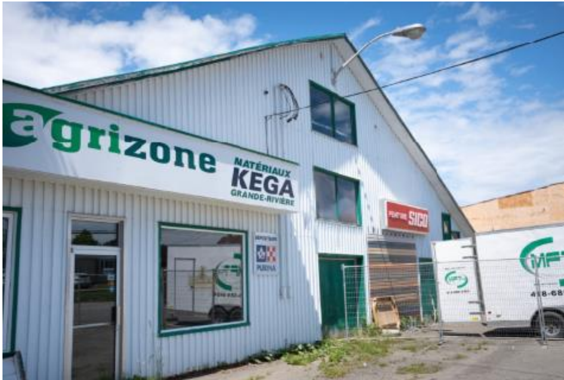
Bâtiment no.1 du BMR avant la déconstruction
