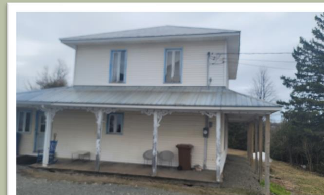
Maison de NR Duguay à déconstruire (Pabos)
