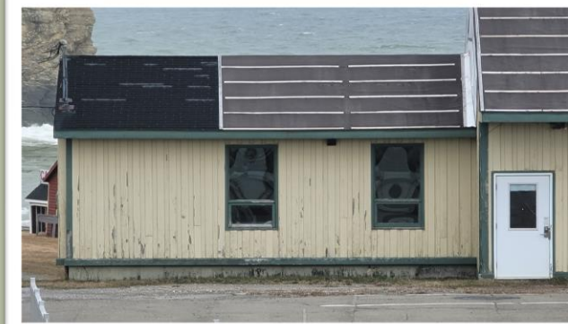
Ancien bâtiment de la Sûreté du Québec (Percé)
